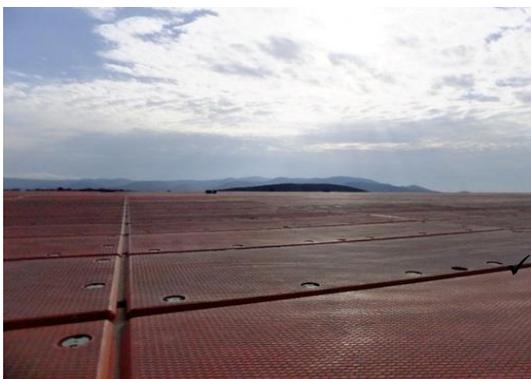
**Мобильные дорожные покрытия (МДП) «МОБИСТЕК»** представляют собой композитное изделие, состоящее из стеклопластика и наполнителя.
