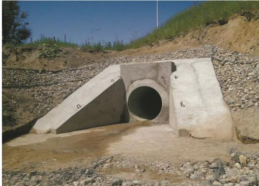
Стеклопластиковые водопропускные трубы «СТЕКОН» представляют собой искусственные сооружения, предназначенные для пропуска постоянных или периодически действующих водотоков под насыпями автомобильных и железных дорог.
