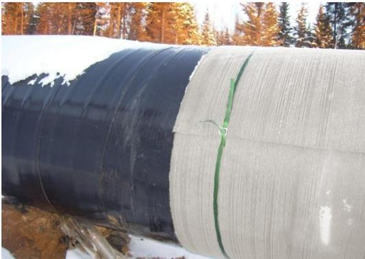
**Мультиаксиальный скальный лист «ГРИНКОД»** представляет собой композит, изготовленный на основе современного высокопрочного материала из стекловолокна и нетканого синтетического полотна, пропитанный экологически безопасными термопластичными смолами.
